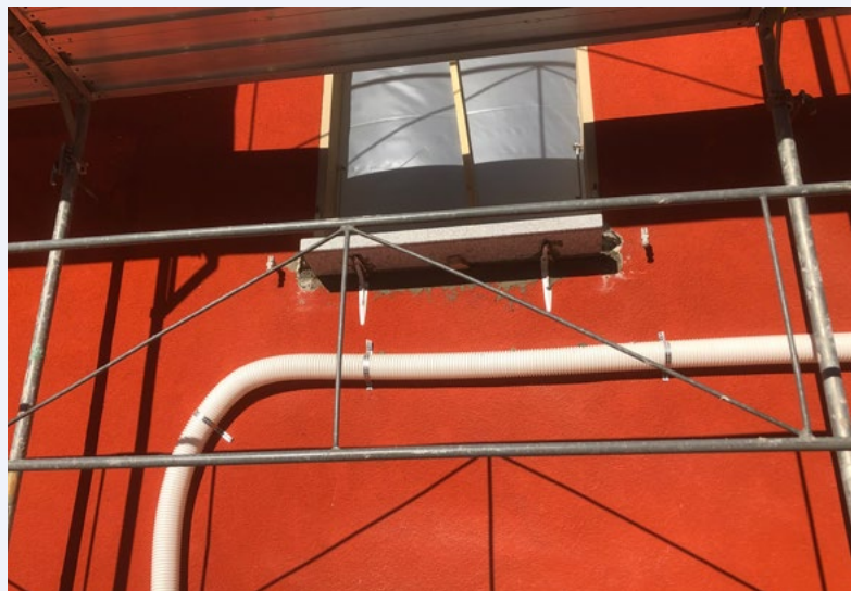
Dopo l'isolamento la parete della casa è più spessa di circa 20 cm e i nuovi tubi di ventilazione passano attraverso lo strato isolante.
