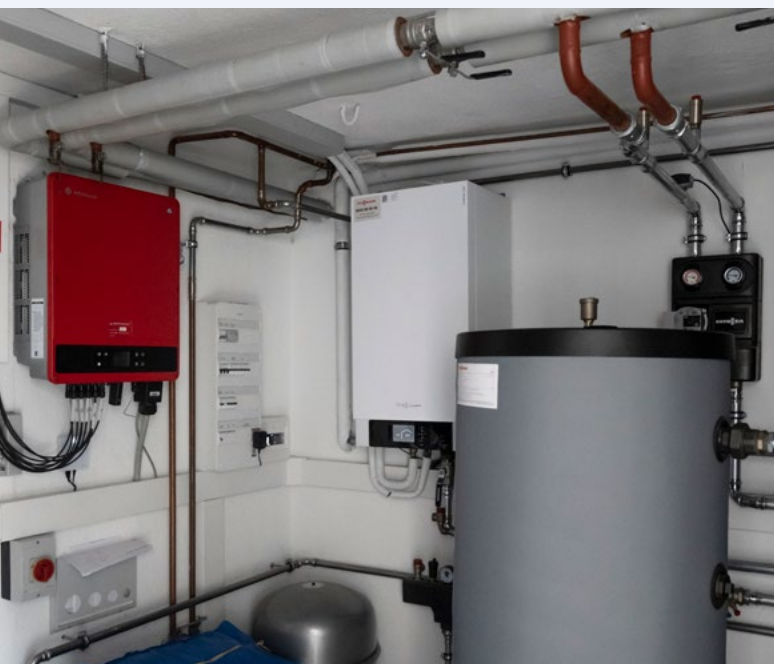
Dopo aver rimosso l'impianto di riscaldamento elettrico, la famiglia ha ricavato più spazio in cantina.
